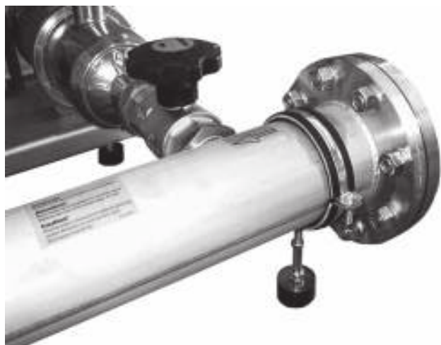
Рис. 9 Схема промывки установки повышения давления
